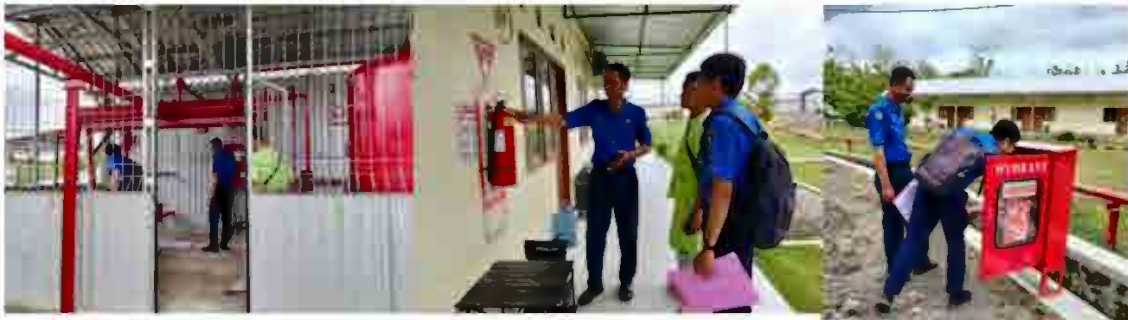
Gambar 3 21. Inspeksi Peralatan Proteksi Kebakaran Tahun 2025
